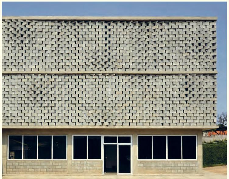
Fachada de coBLOgo, de SUBdV Studio, un diseño paramétrico inspirado en el trabajo de Gramazio y Kohler, pero construido con un método low-tech.
