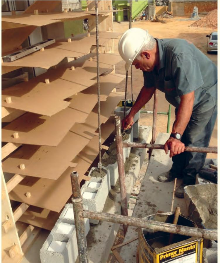
Albañil disponiendo ladrillos mediante el uso de guías de cartón confeccionadas a través de corte láser. Proyecto coBLOgo, de SUBdV Studio.
