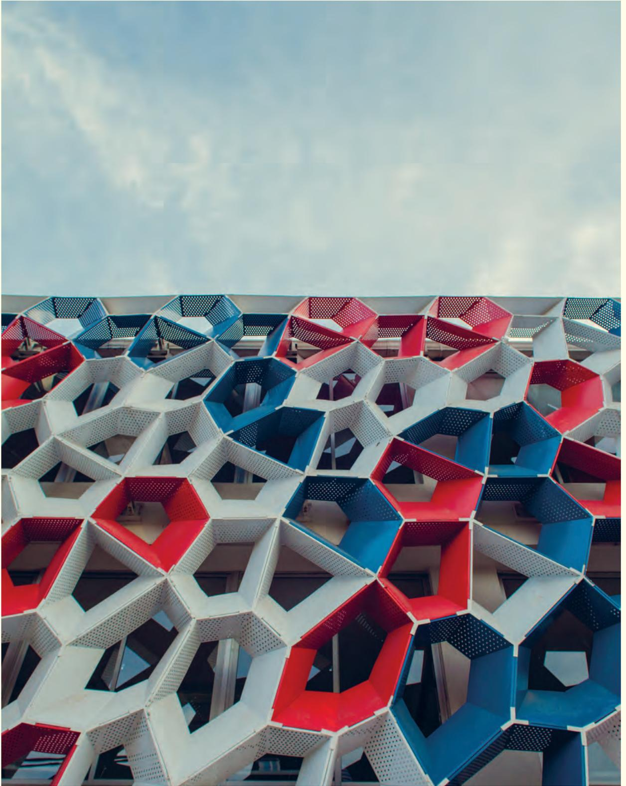
Neutral Voroni, sistema de corte láser y fachada diseñado paramétricamente por la oficina de Bogotá Frontis 3D.
